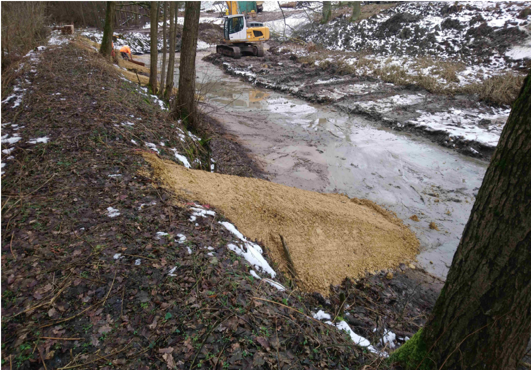
Einbau Aufstiegshilfen an Südufer
