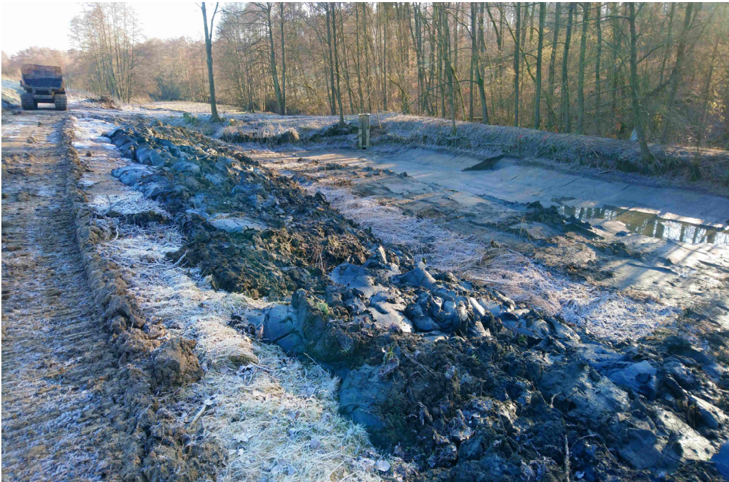
Bodeneinbau an Nordböschung für Geländemodellierung
