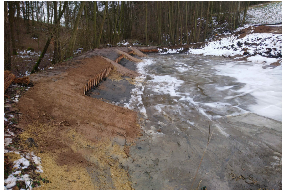
Böschungssicherung mit Faschinen und integrierten Aufstiegshilfen
