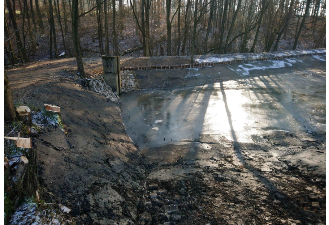
Teich 1 – Ufersicherung Südböschung
