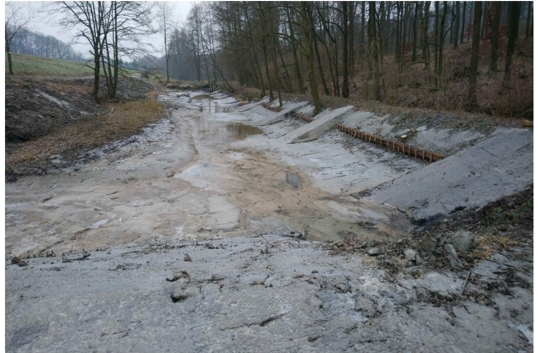
Teich 1 Böschungssicherung mit Faschinen und integrierten Aufstiegshilfen
