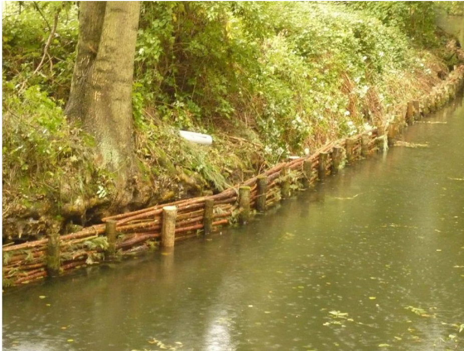
Planung Teich 1 - Blick nach Süd - Einbau Faschinen entlang Südufer
