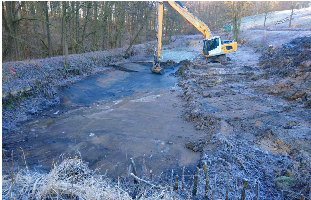
Schlammernahme mit Langstielbagger als Kettenfahrzeug
