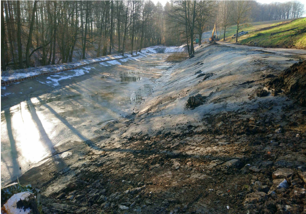
Teich 1 – Modellierung Nordböschung
